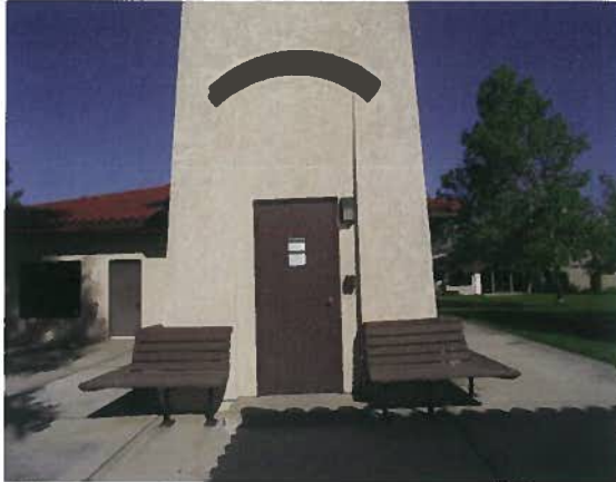
ATT Tower Door
